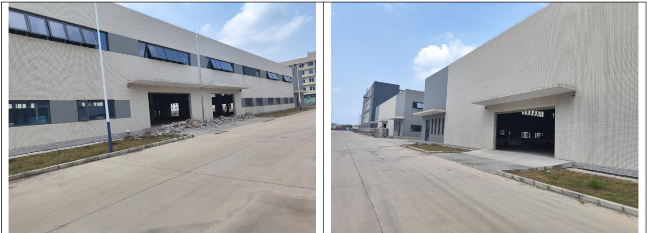
项目东面-空厂房
