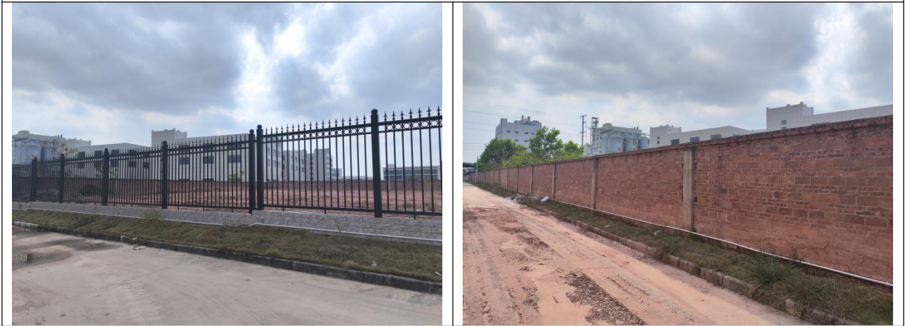
项目西面-空地
