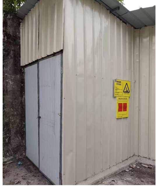
危险废物暂存间
