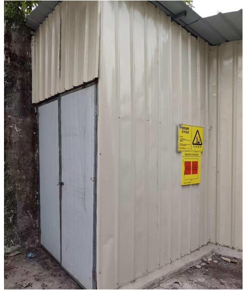
危险废物暂存间
