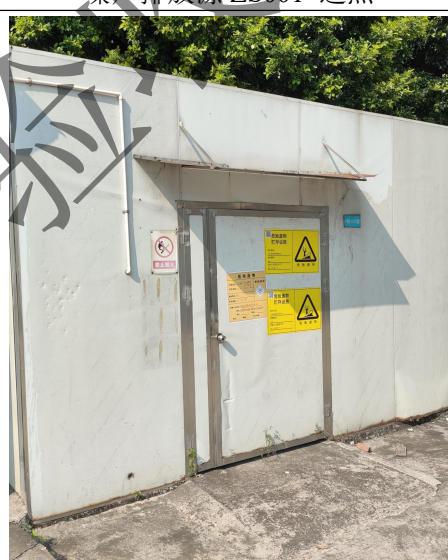
危险废物暂存场 TS001 远照
